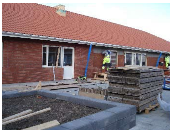
Nybygget Symfonin i Svarte
